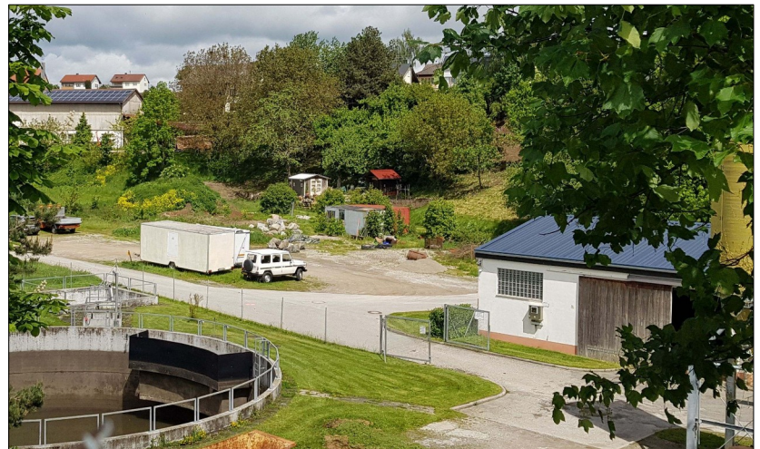
Abb. 3.1-11: Ansicht aus Südosten auf die Erweiterungsfläche 2. Im Vordergrund Einrichtungen und Gebäude der bestehenden Kläranlage
